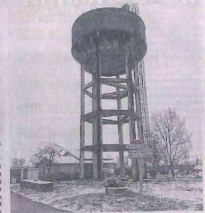
Le château d'eau de Saint-Maurice-de-Rémens, pièce maîtresse du dispositif de distribution d'eau potable. Photo Patrick Guinot
